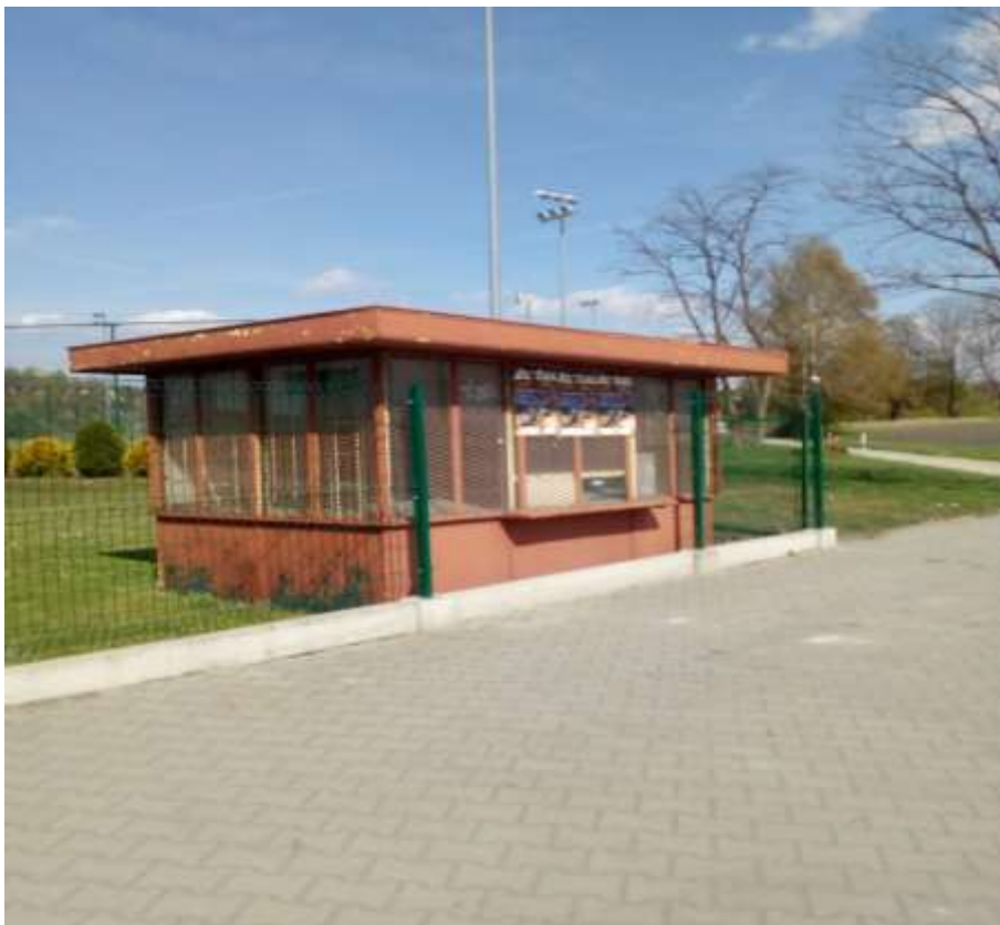
Budynki na terenie obiektów sportowych przy ul. Legionów
