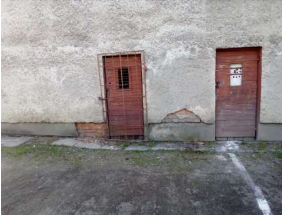
Budynki na terenie obiektów sportowych przy ul. Legionów
