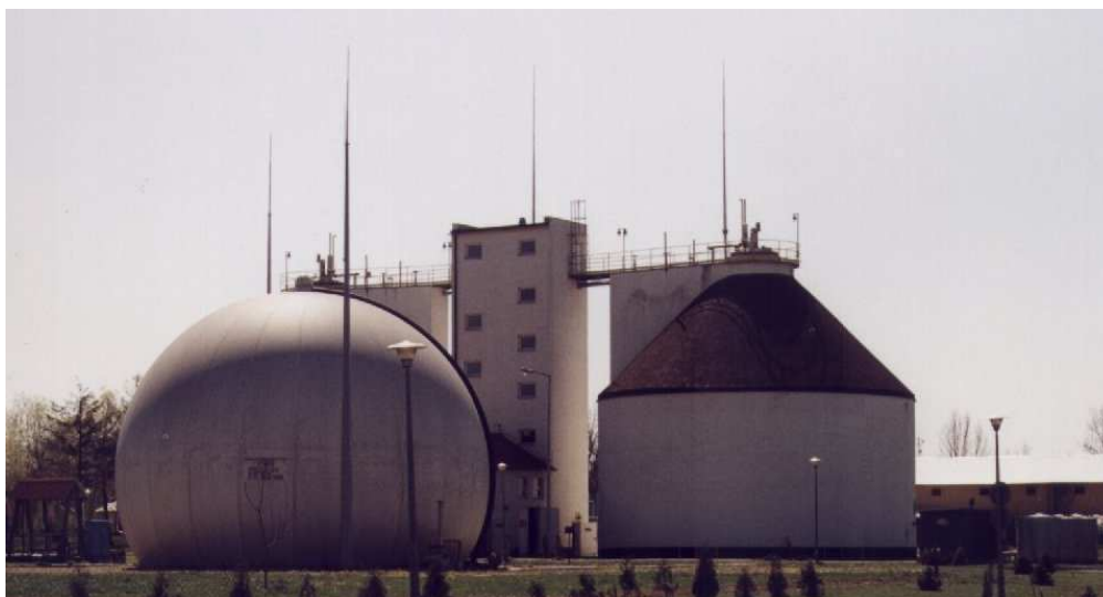
Fot. 3 Wydzielona komora fermentacyjna (WKF) oraz zbiornik gazu
