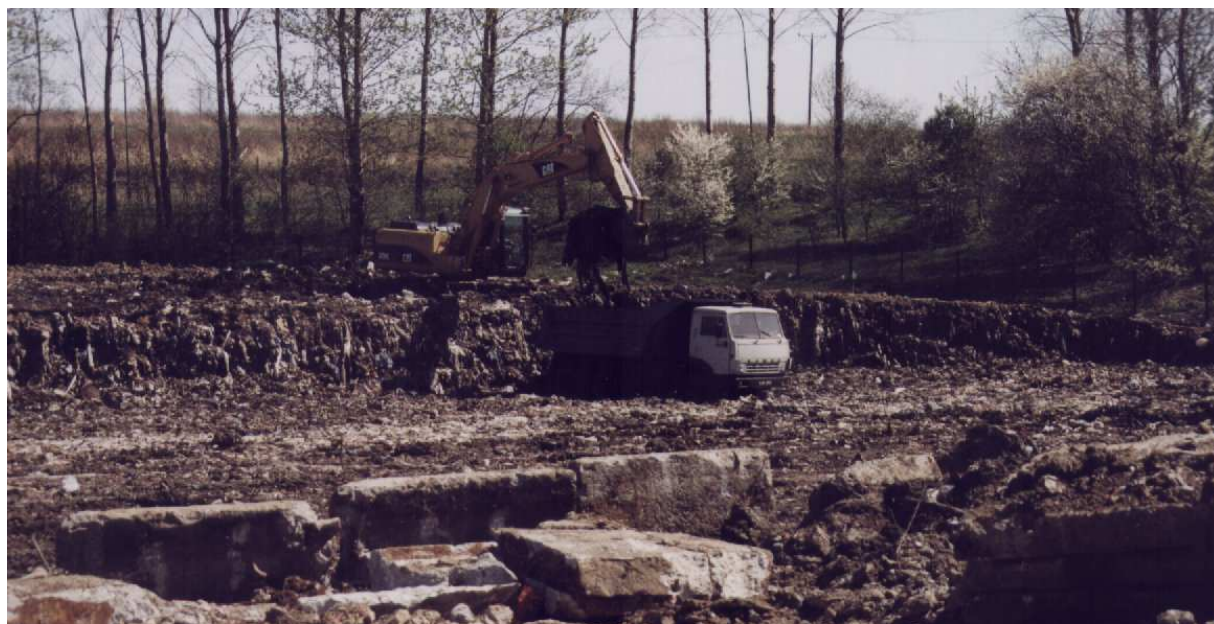
Fot. 9 Teren pod nowobudowany ZUOK
