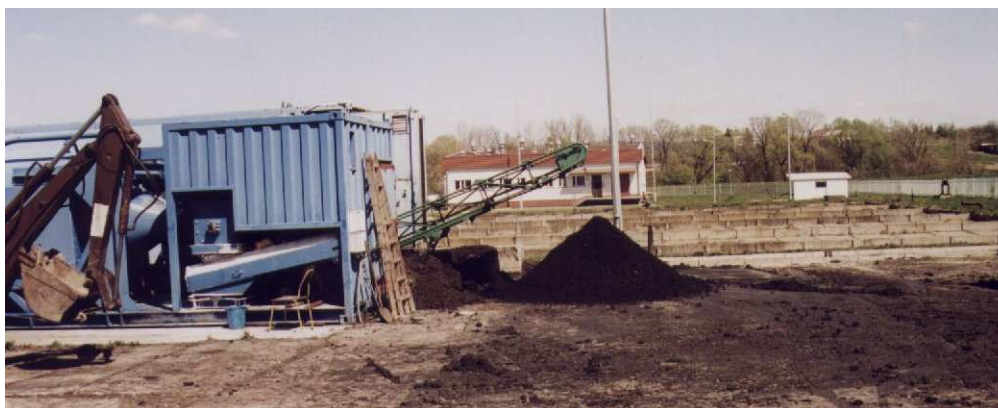
Fot. 4. Prasa filtracyjno-taśmowa
