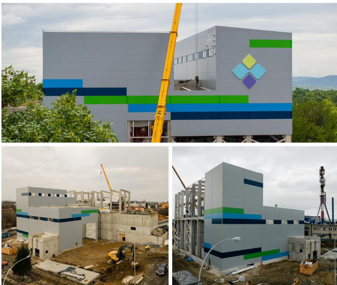
Fot. 8. Budowa bloku energetycznego opalanego pozostałościami z sortowania odpadów komunalnych na terenie Elektrociepłowni Łężańska, fot. archiwum Krośnieńskiego Holdingu Komunalnego
