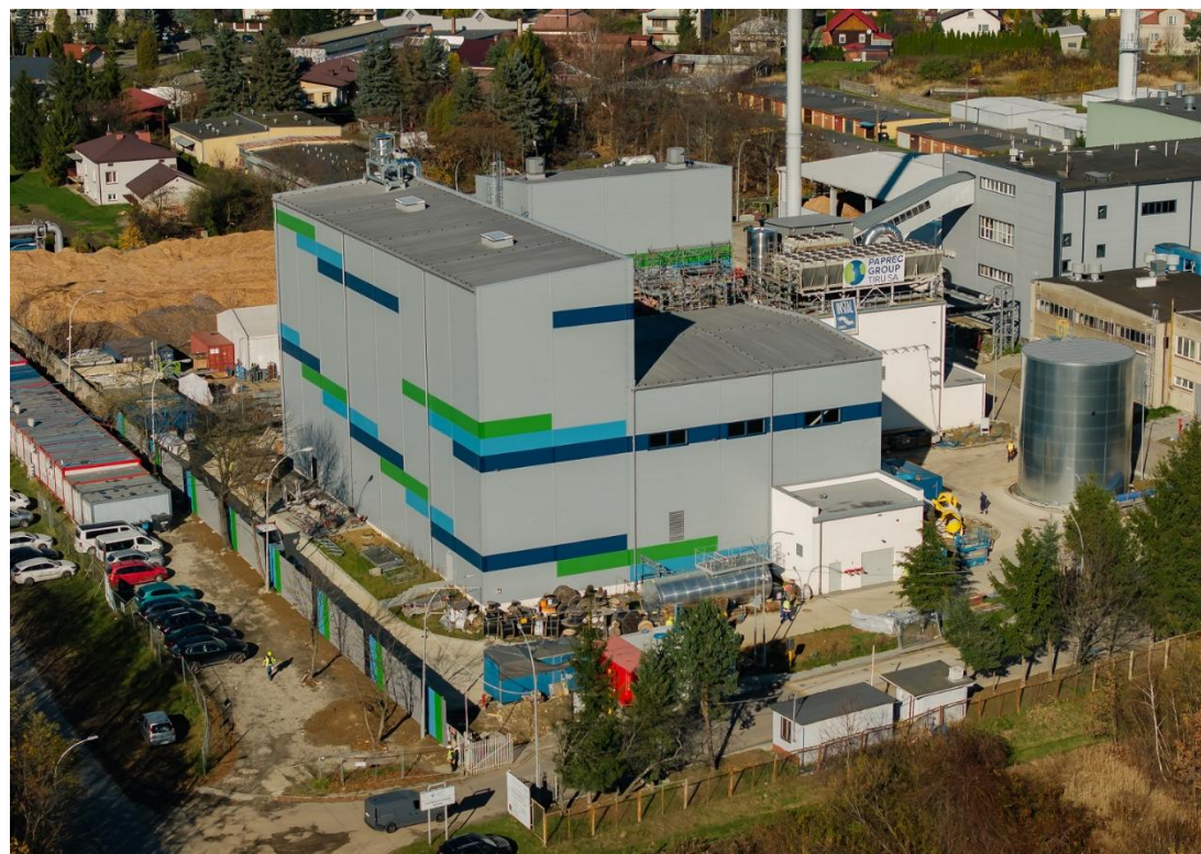
Budowa bloku energetycznego. Fot. Krośnieński Holding Komunalny
